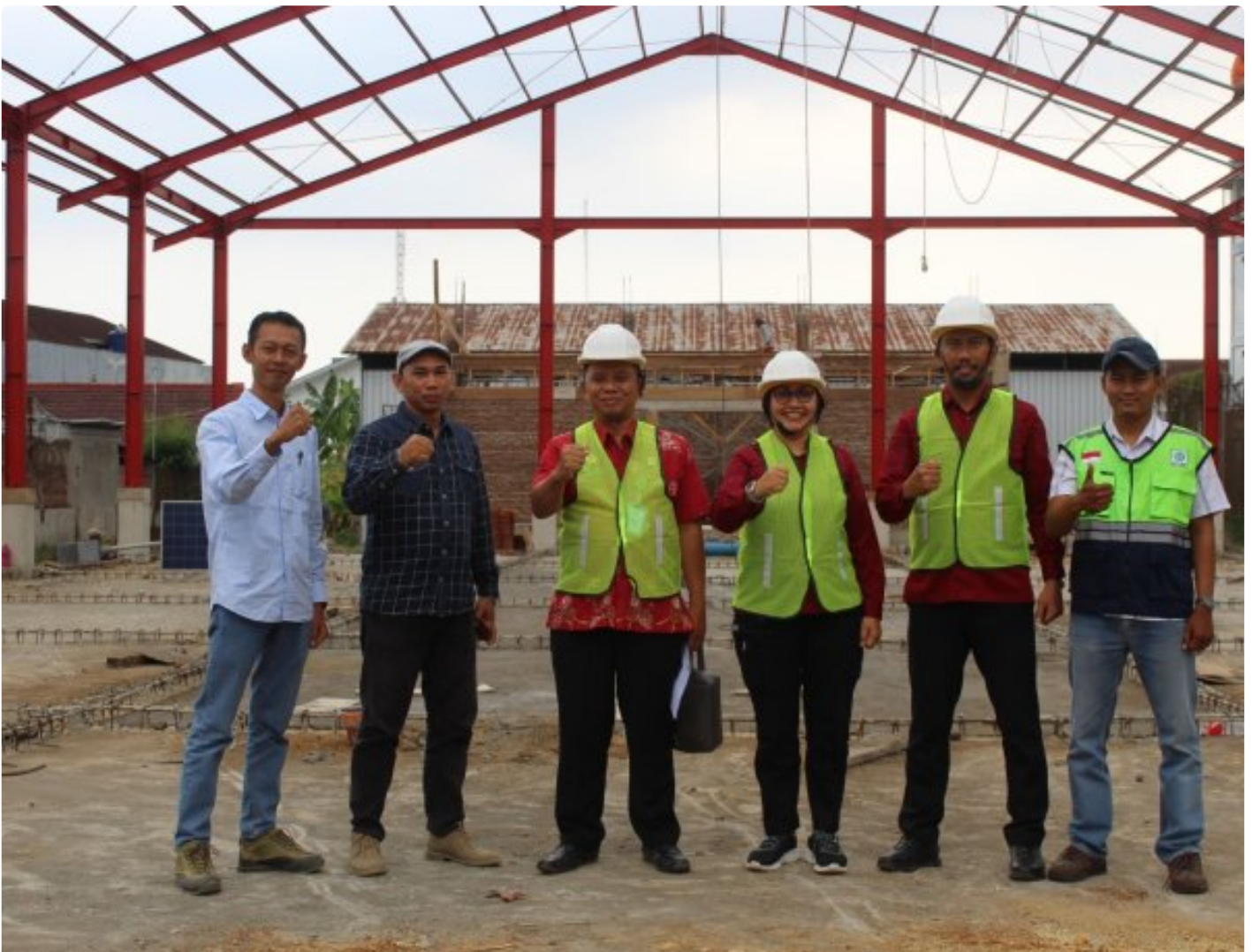
UKPBJ Setwil Jateng Tinjau Progres Pembangunan Gudang Basan Baran Rupbasan Purwokerto
